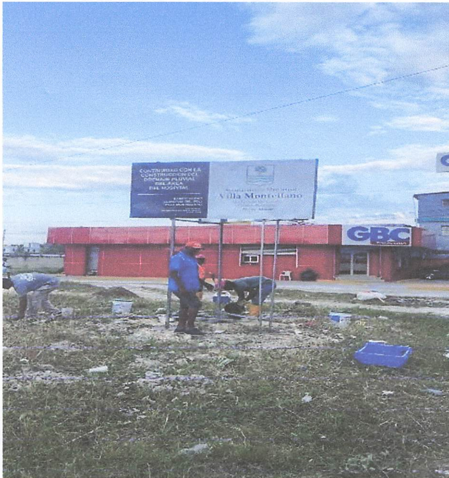
Instalación vaya de identificación del proyecto.
