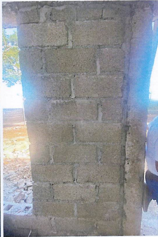
Fig. 10: Inexistencia de serpentinas o llaves de adherencia en muros frontales pertenecientes a la nueva fachada, lo que reduce la resistencia de los muros a diversos esfuerzos e incrementan el riesgo de fisuras - Funeraria Municipal de Montellano, Montellano, Puerto Plata, Rep. Dom.
