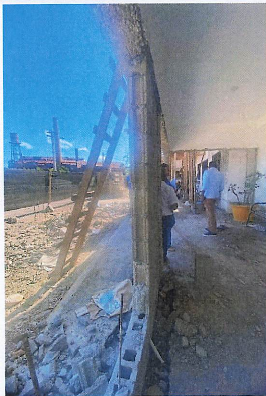
Fig. 10: Inexistencia de serpentinas o llaves de adherencia en muros frontales pertenecientes a la nueva fachada, lo que reduce la resistencia de los muros a diversos esfuerzos e incrementan el riesgo de fisuras - Funeraria Municipal de Montellano, Montellano, Puerto Plata, Rep. Dom.
